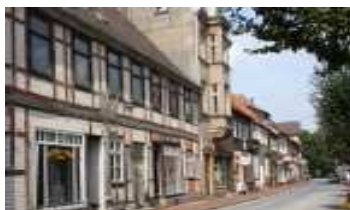
Nicht alles ist renoviert.
